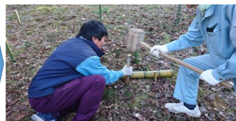
斜面に土留め設置
