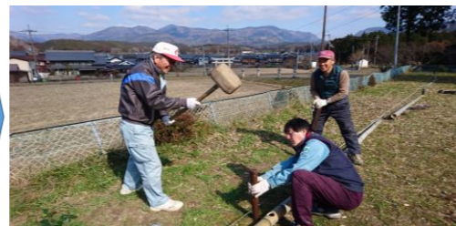
竹車止め設置作業
