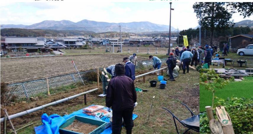
植栽準備 駐車場なので、 地盤が堅い
