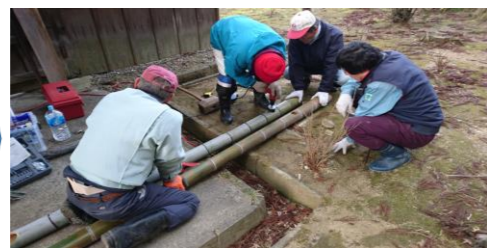
竹車止めの工作(穴開け作業)
